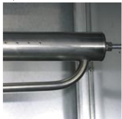
Dampfbefeuchterlanze mit Düsen
