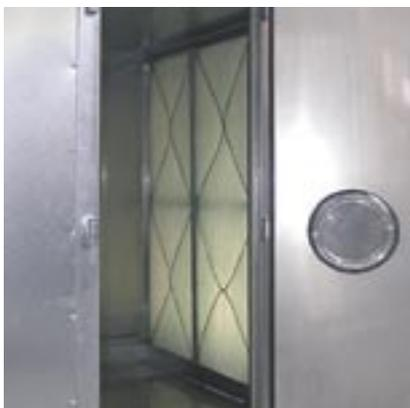
Tropfenabscheider für Hochdruckbefeuchter
