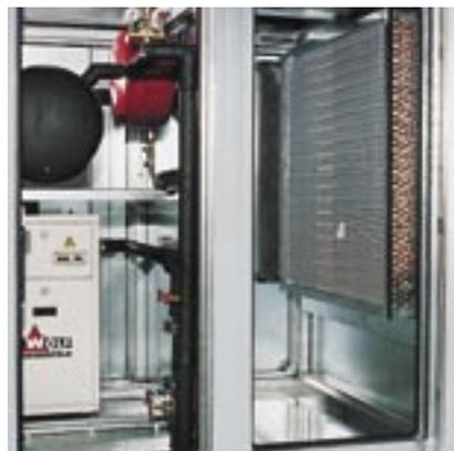
Indirekte Kühlung mit Kaltwassersatz
