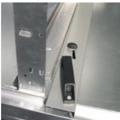
Klemmschiene für Filterrahmen
