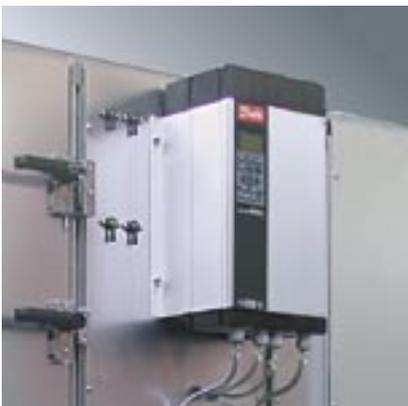
Frequenzumformer (FU) für stufenlose Regelung der Ventilator Drehzahl
