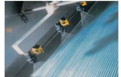
Wärmerückgewinnung in Lüftungs- und Klimaanlage und gleichzeitig Kühlung der Zuluft im Sommer.
