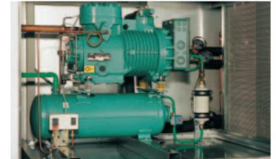
Komplette Kälteanlage mit halbermetischem Verdichter. Geeignet für stufenlose Leistungsregelung der Drehzahl, mit Kältemittelsammler, Kältemitteltrockner, Schauglas, Hoch- und Niederdruckschalter, Öldruckschalter, Thermoschutzschalter für Kompressor.
