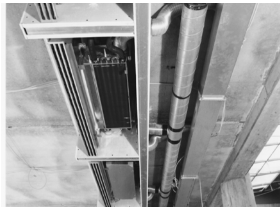
Montaż systemu Indivent®
